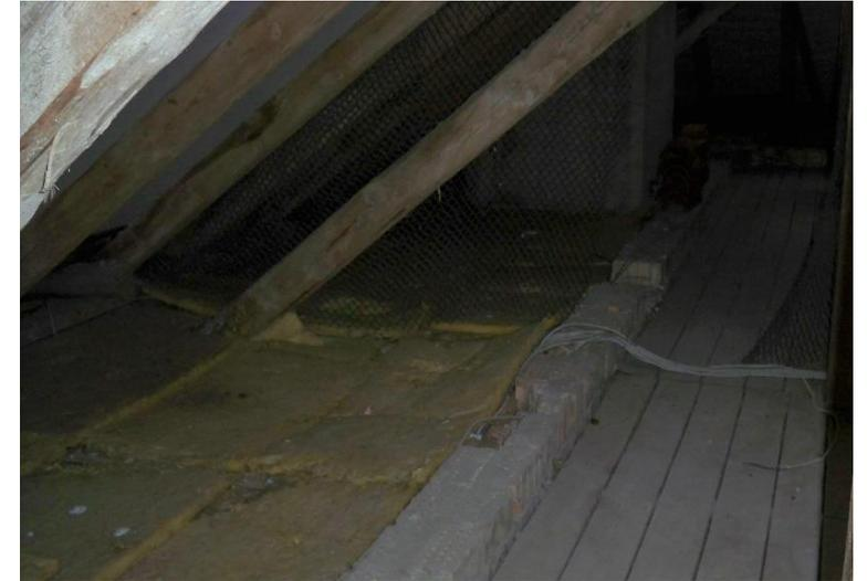
Bsp. Bestandsdach – gute Voraussetzungen für eine einfache Dämmung der Geschossdecke
