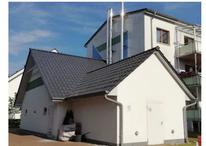
Zentrale Wärmeerzeugung im Quartier
