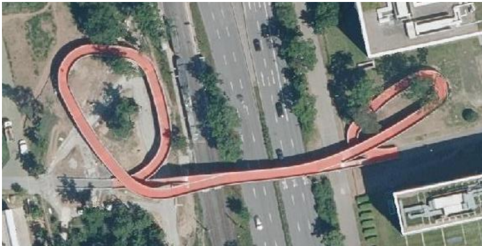
Abbildung 84: Fuß-/Radverkehrsbrücke über die Rheinstraße in Darmstadt, 2019. (Geoportal Hessen)
