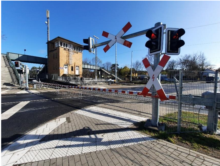
Abbildung 7: Bahnübergang am S-Bahnhof Borgsdorf (eigene Aufnahme)
