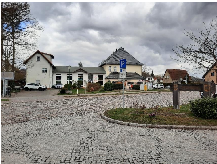
Abbildung 5: Fahrbahnbelag Berliner Straße / Fürstenauer Platz (eigene Aufnahme)
