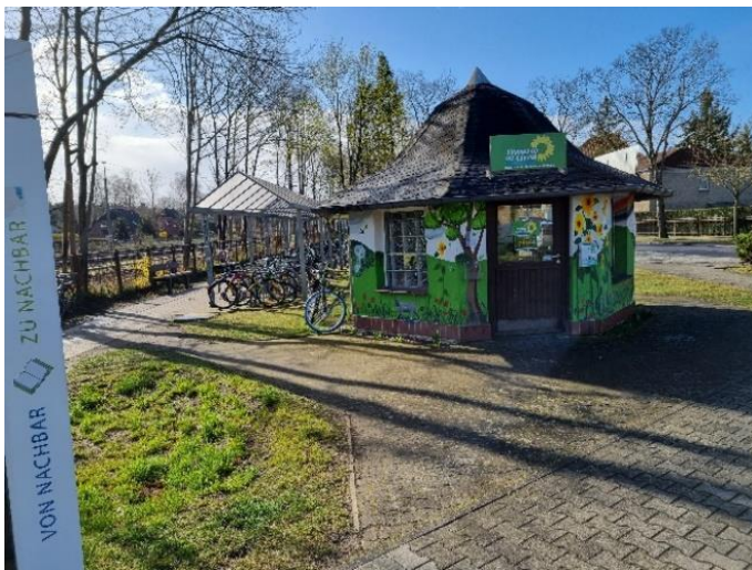
Abbildung 51: Kleingebäude, Fahrradabstellanlage (Foto: agu Goldmann)
