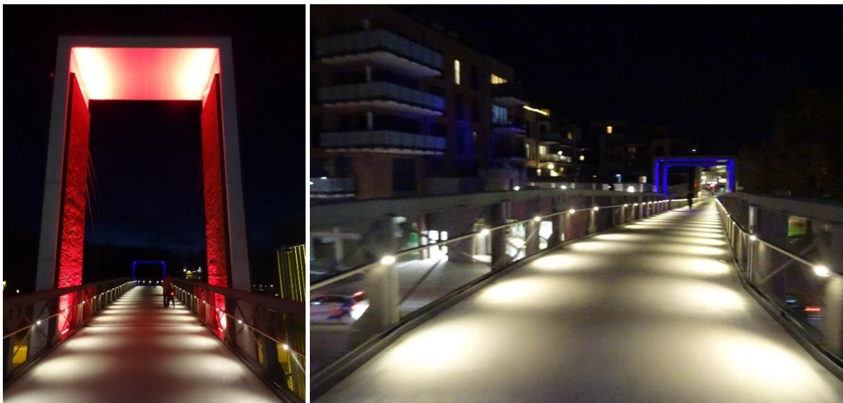
Abbildung 85: Fuß-/Radbrücke über die Eisenbahn in Vechta, 2018. (Fotos: stadtraum)
