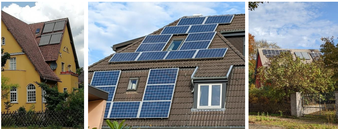
Abbildung 19: Dachnutzung für regenerative Wärme- und Stromerzeugung (Fotos: BBP)
